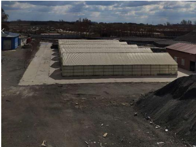
西侧浩宁建筑材料厂
